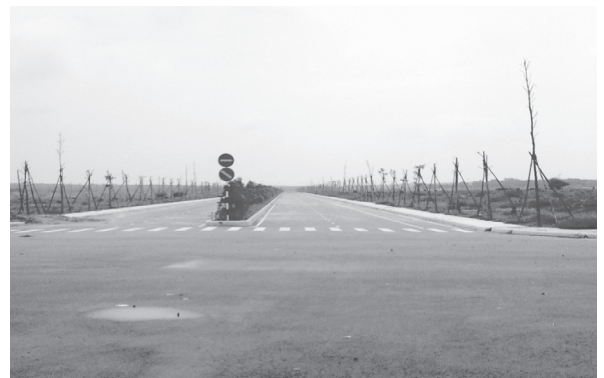
Cơ sở hạ tầng tại cụm công nghiệp Phú Chánh
